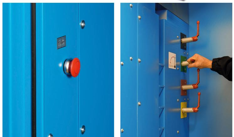
Die Steuerung der Düsengruppen erfolgt über Taster (linkes Bild) oder über „Kugelhähne“ (rechtes Bild). Sowohl Bedienteile als auch Düsengruppen sind farblich gekennzeichnet. Die Bedienteile haben die Farben der jeweiligen Düsengruppe. Dadurch ergibt sich eine eindeutige Zuordnung, denn es kann entweder die ganze Arbeitskleidung oder nur ein Teil davon abgeblasen werden.
